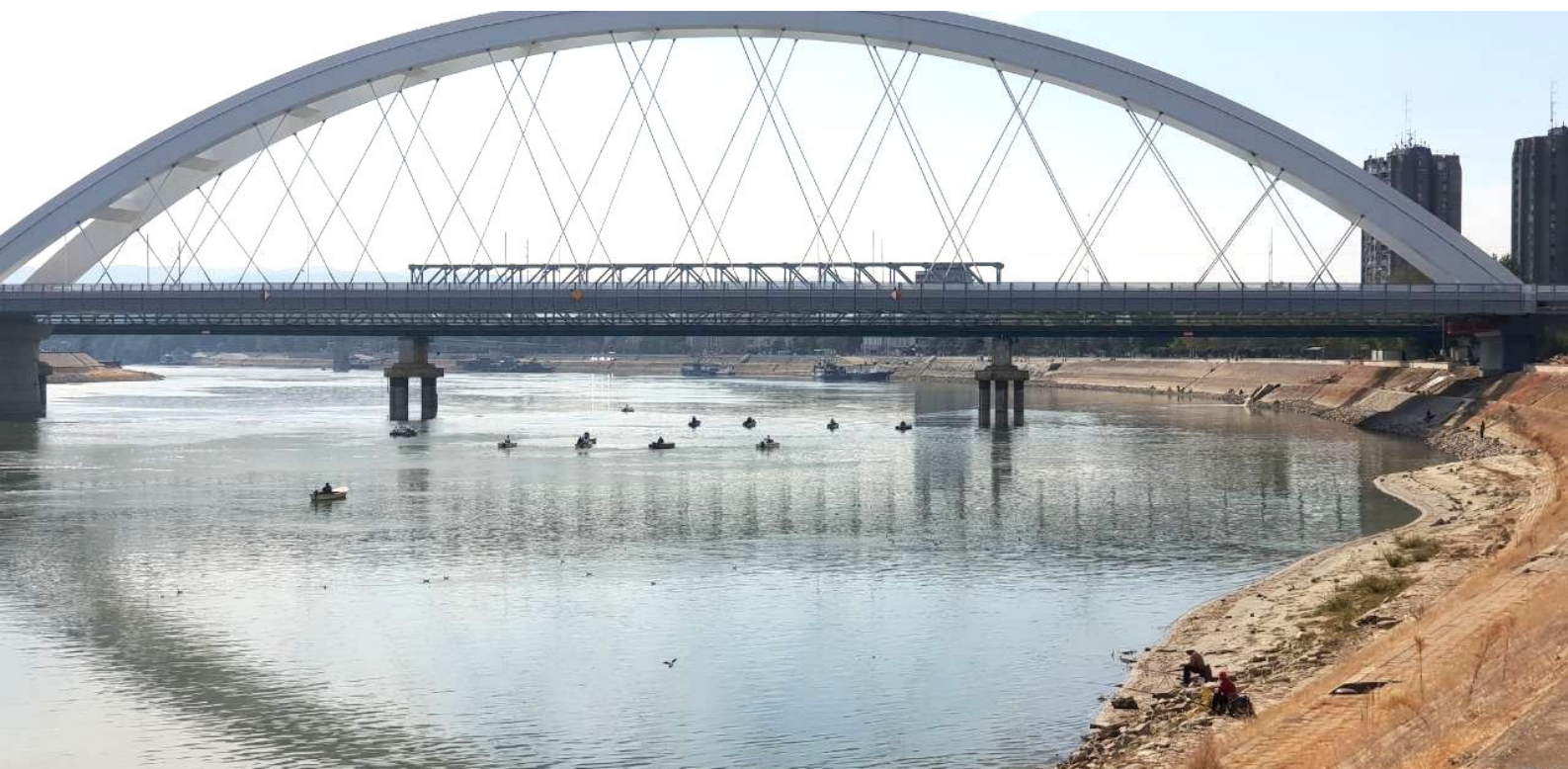
Plovidbeni prolaz mosta Boško Perošević u Novom Sadu 06.10.2018.(FOTO)
